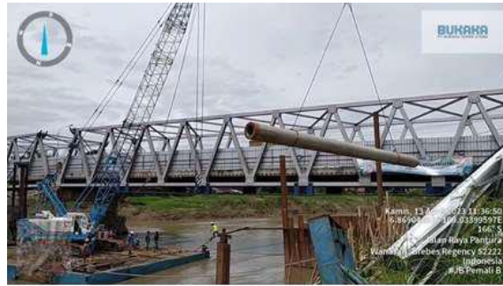
Gambar 15. Pemindahan Spun Pile
