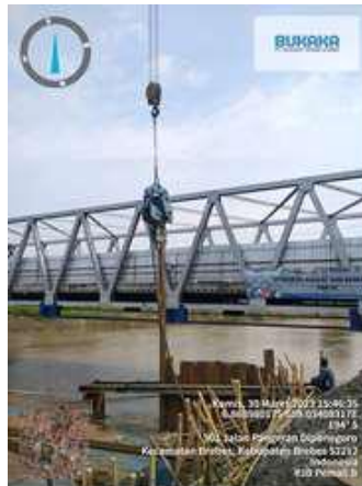
Gambar 9. Pemasangan SSP
